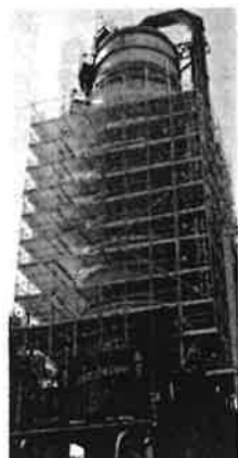
保温材設置工事現場の様子
